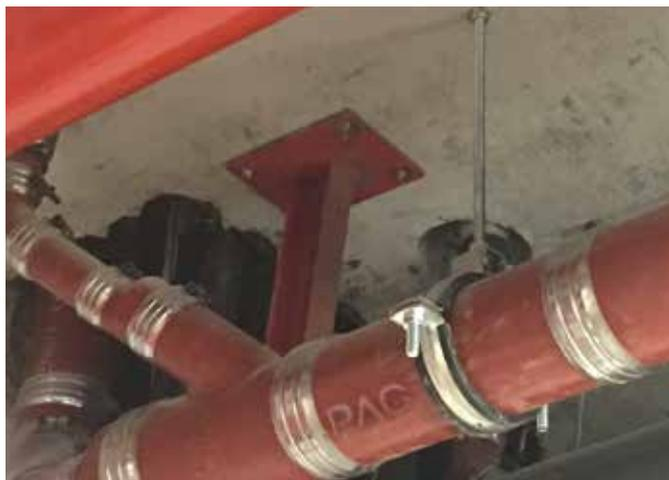
Тяжелые зажимы с резиной подразделяются на два в качестве тяжелых зажимов с гайкой и крепкими зажимами с головкой.
