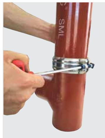
Применить крутящий момент с помощью гаечного ключа, пока замки не соприкоснутся друг с другом. Прекратить фиксацию при контакте.
